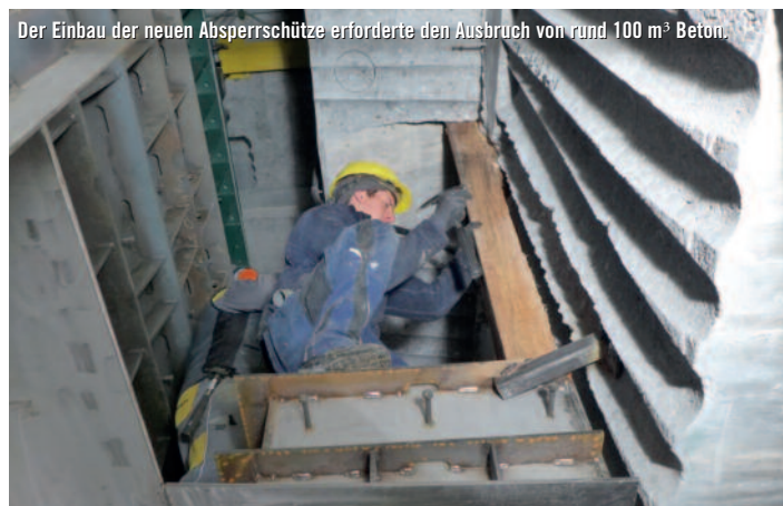
„Doppelt hält besser“ trifft nun auch auf den Stahlwasserbau der Tiroler Talsperre zu. 2,7 mal 2,7 m misst die neue Ablassschütze.
