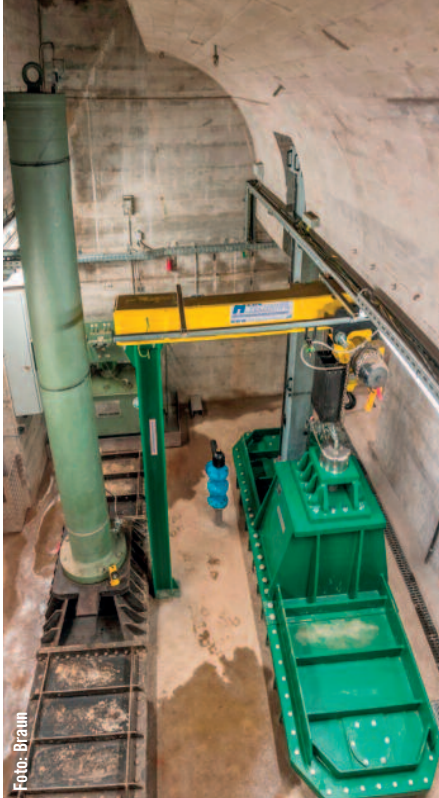
Das neue Absperrorgan (rechts am Bild) wurde hinter der bestehenden Schützenanlage eingebaut.
