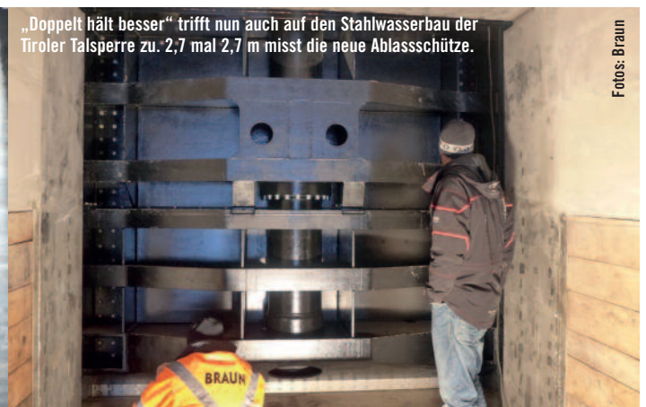
Der Einbau der neuen Absperrschütze erforderte den Ausbruch von rund 100 m 3 Beton.
