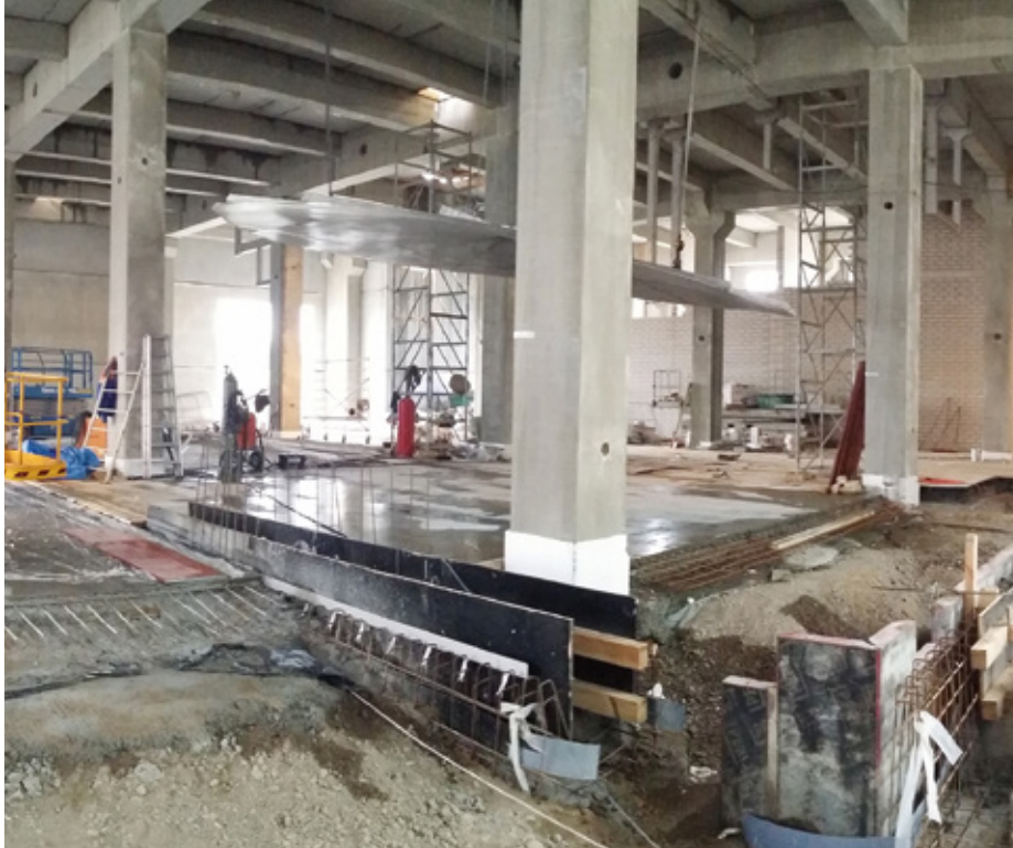
Die Fundamentarbeiten für die Verlängerung der Papiermaschine wurden bei laufendem Betrieb ausgeführt.
