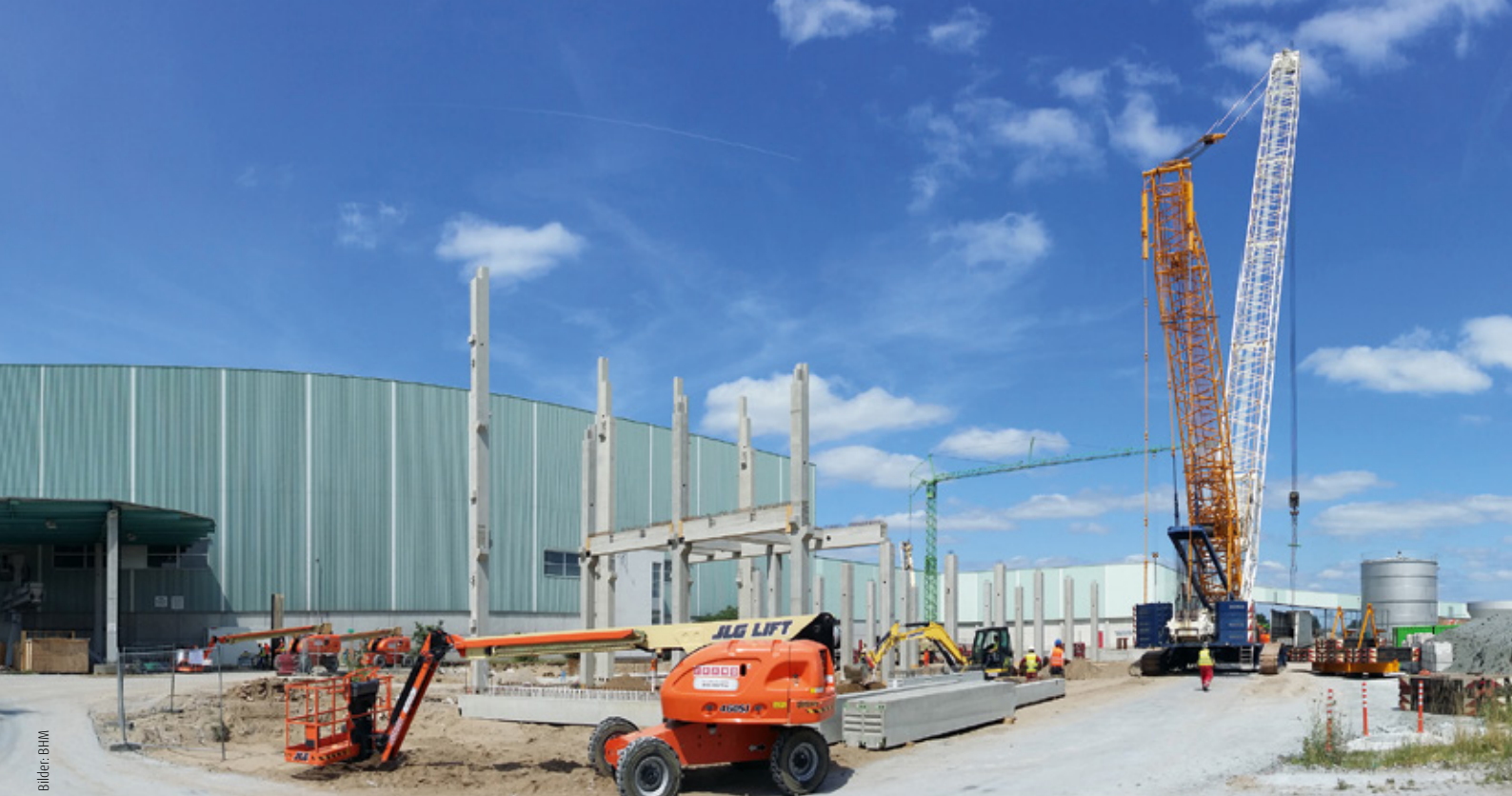
Bei der Errichtung der neuen Stoffaufbereitung ist ein schwerer Raupenkran im Einsatz.
