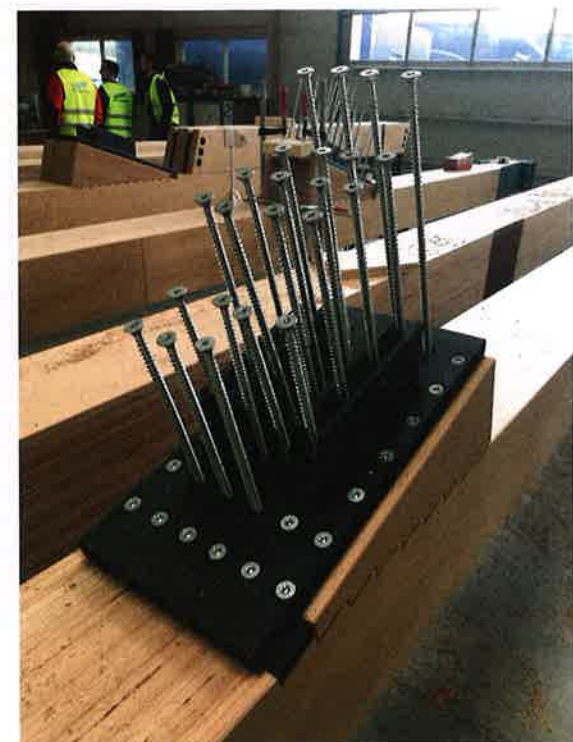
Haupt-Fachwerkbinder: Anschluss von Diagonale und Pfosten über ein Koppelungsstück aus Stahlplatte und Knagge mit „verlängertem“ Treppenversatz an den Untergurt
