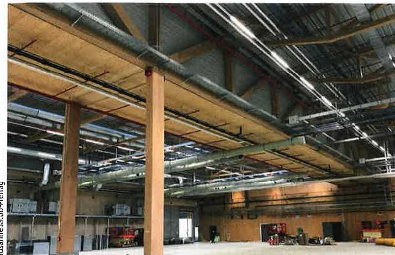
Buchen-FSH ermöglicht es, die Feldweiten von 40 m bzw. 42 m mit filigranen Träger-Abmessungen zu überbrücken.
