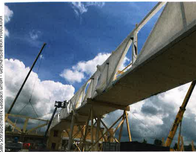
Die Shed-Gräben werden auf Montageböcken aufgelagert, die erst entfernt werden können, wenn das Tragwerk vollständig montiert und damit kraftschlüssig ist.
