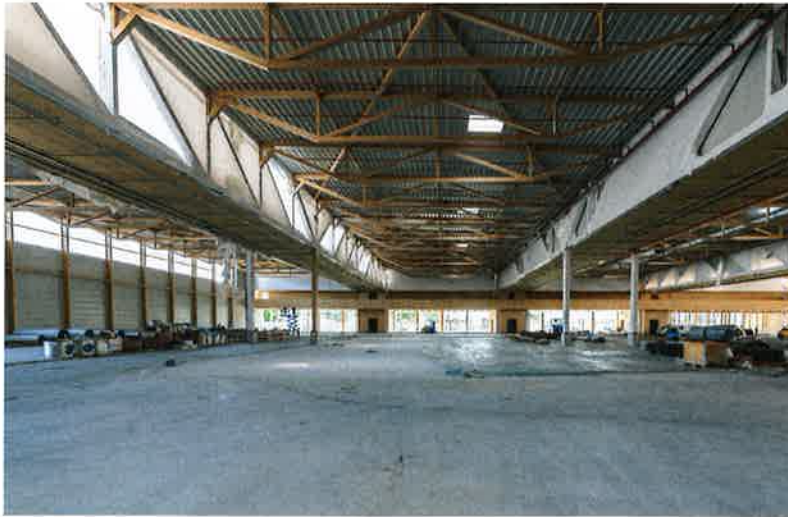
Blick in die Halle mit nur einer Zwischenstütze je Haupt-Fachwerkbinder (bzw. zwei Stützen je Shedgraben), sodass diese als Zweifeldträger fungieren.
