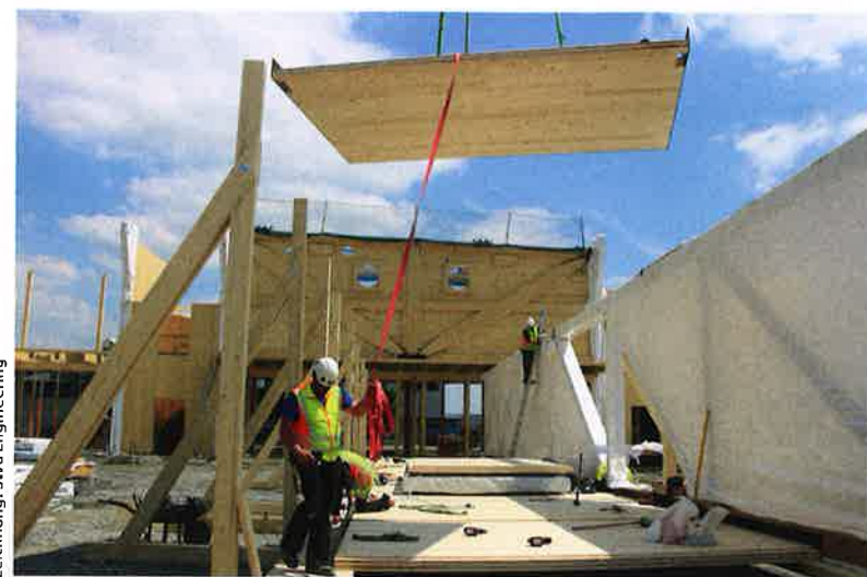
Die 12 cm dicken BSP-Platten der Shed-Gräben sind als Deckenscheiben ausgebildet und mit den Untergurten der Haupt-Fachwerkträger verschraubt, um sie gegen seitliches Ausknicken infolge von Druckkräften zu fixieren. Im Hintergrund: Die wandartigen Träger an den Stirnseiten der Hallenschiffe.
