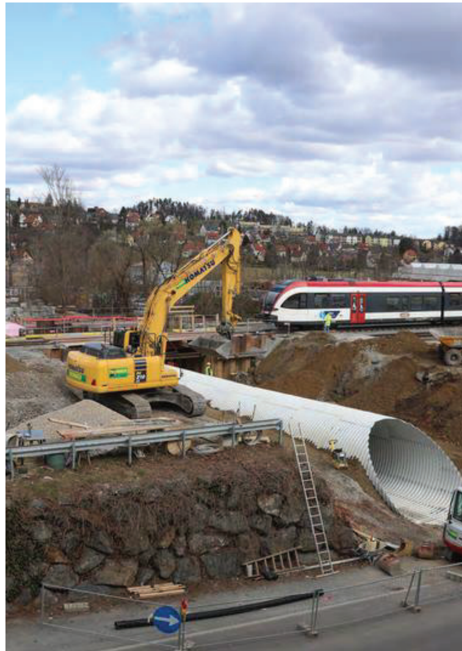
Hochmodernes Unterführungsbauwerk aus Wellblechstahl wird in Deutschlandsberg errichtet
