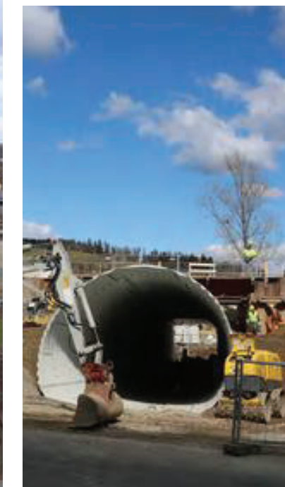
Stabil trotz schneller Errichtung
