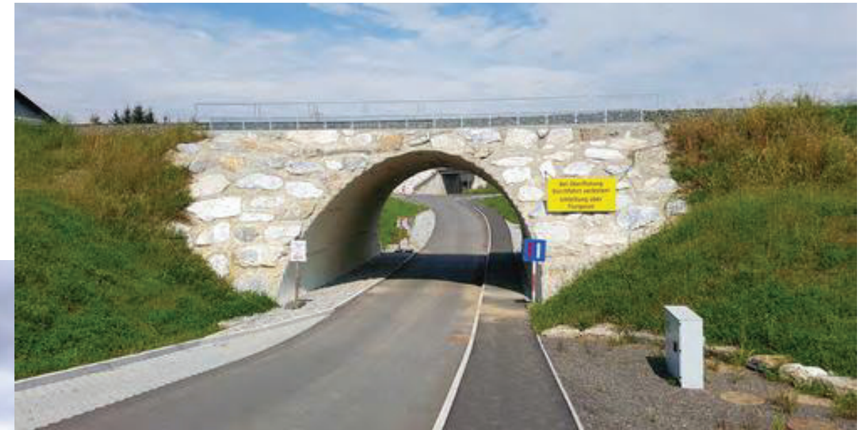
Moderne Wellblechstahlunterführung mit Natursteinverbauung in der Liebocher Flurgasse
