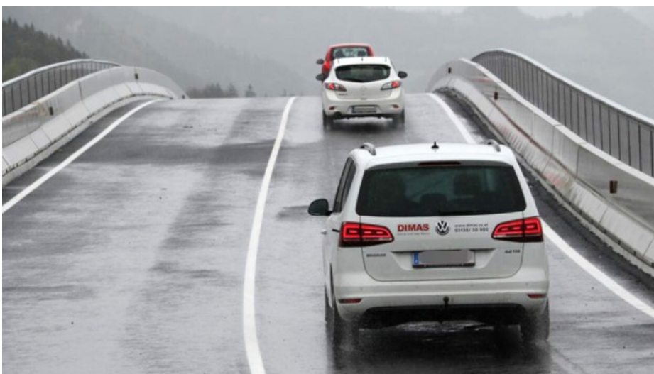
Die Grimmingbrücke kann jetzt befahren werden!(Bild: Christian Jauschowitz)
